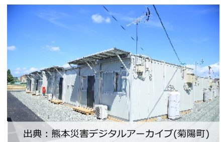
仮設住宅（建設型）の例
