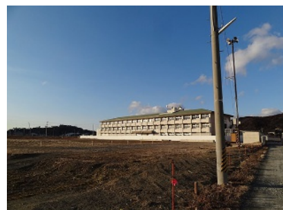
工事が遅れている復興事業用地
