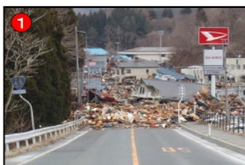
岩手県宮古市国道 45 号の被災状況
