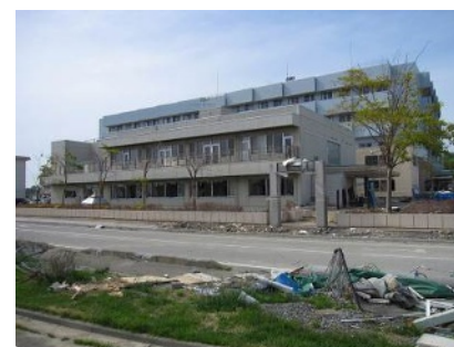
津波により被災した病院施設
