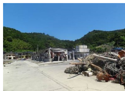
津波により被災した漁港施設
