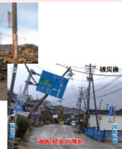
液状化による地盤の流動状況（内灘町）
