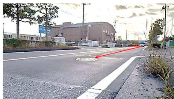
既存のマンホール（約 150m）
