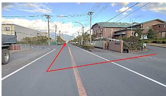
ききょう東側の既存マンホールへ接続
