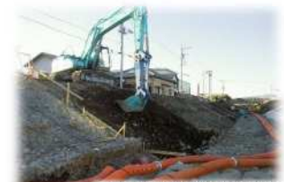
富士早川改修工事の様子
